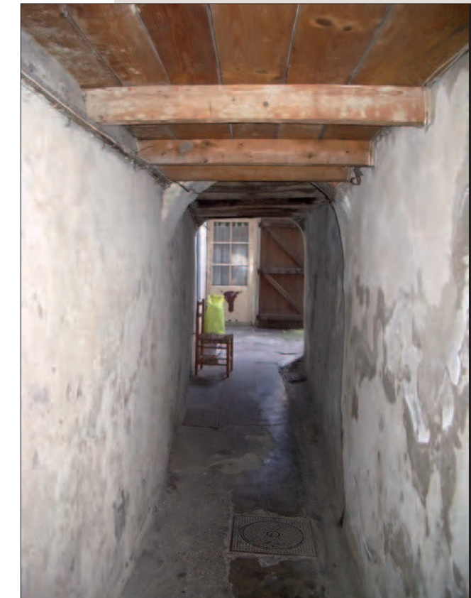
Passage à conserver, 44 rue du Refuge
