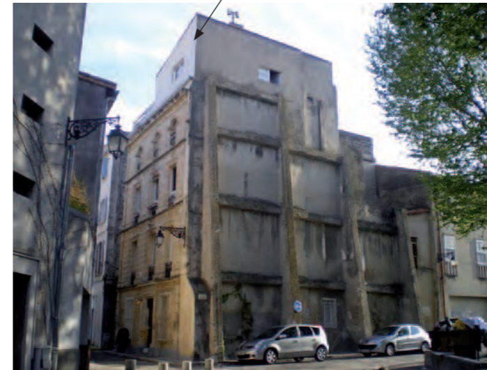
Écrêtement, 12 rue Chiavary
