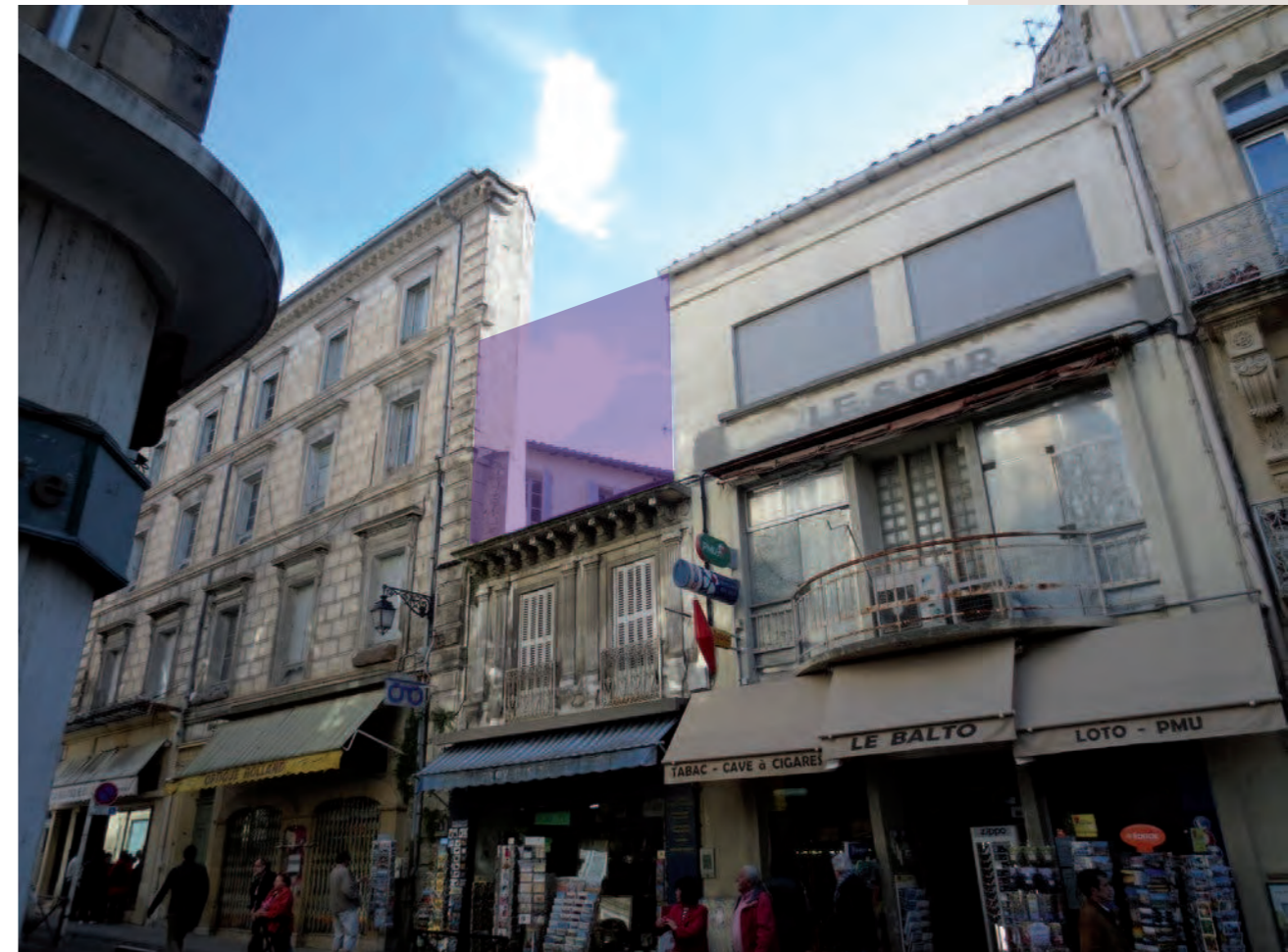
Surélévation possible, rue Jean Jaurès
