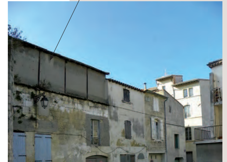
Écrêtement, rue Laincel sur emprise de l'église Saint-Laurent
