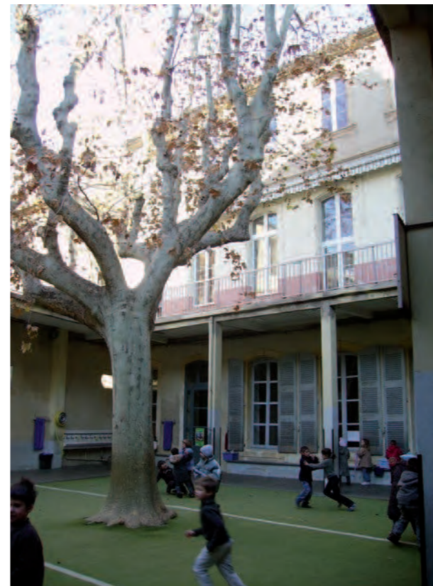
Cour à conserver, 4 rue Tour du Fabre
