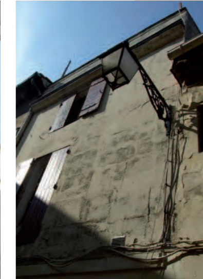
Restitution d'un couronnement, 12 rue Montille
